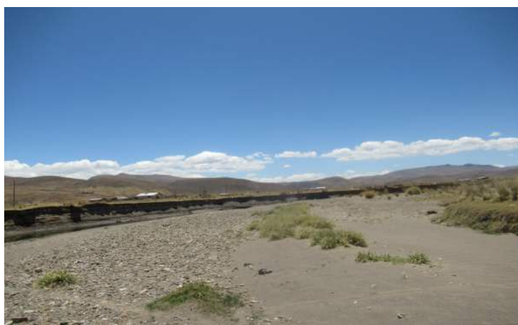
FIGURA N°03: SE PUEDE APRECIAR LA COLMATACIÓN EN LA MARGEN IZQUIERDA Y EROSIÓN DEL PIE DE TALUD EN LA MARGEN DERECHA DEL RIO PUNCURE TRAMO PARA DESCOLMATAR Y CONFORMAR BORDOS CON MATERIAL PROPIO EN AMBAS MARGENES.
